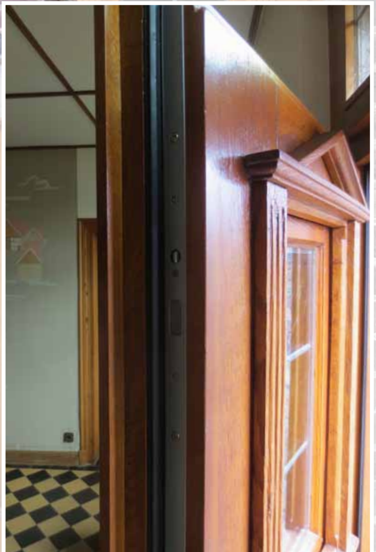
Modernes Haustürschloß mit Dreifachverriegelung und Profilzylinder.
