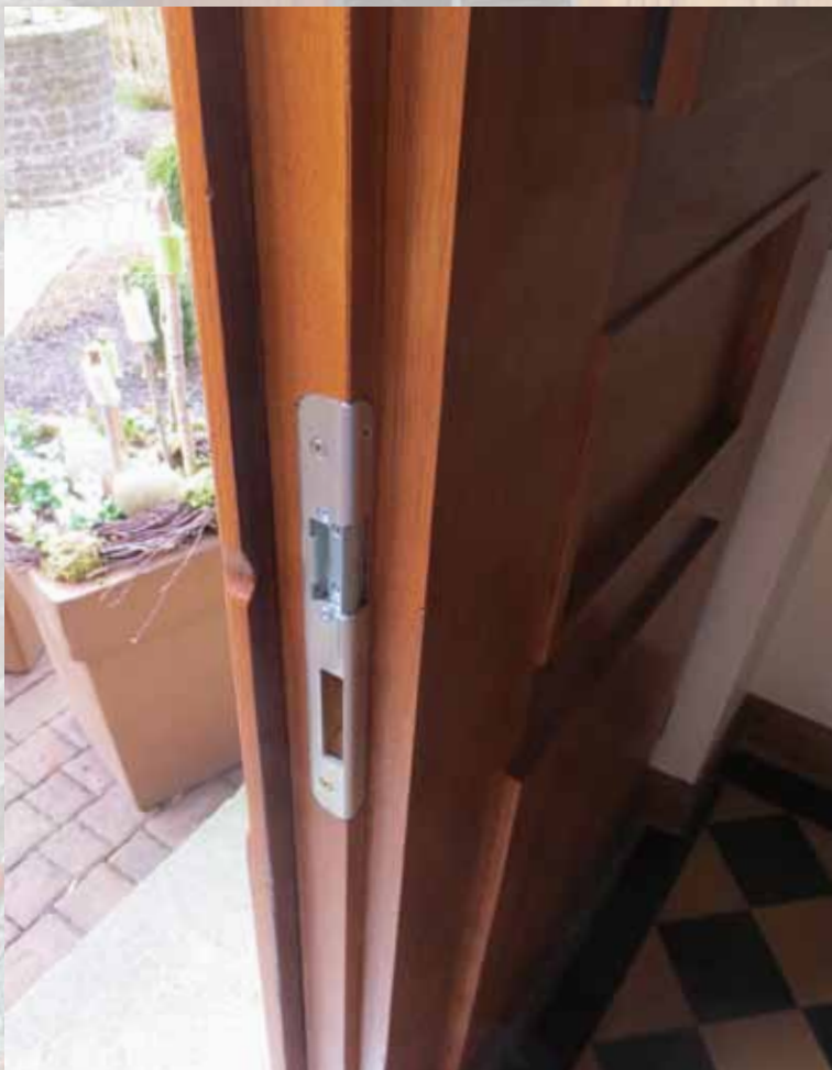
Der neu eingearbeitete Sicherheitsschließblech.
