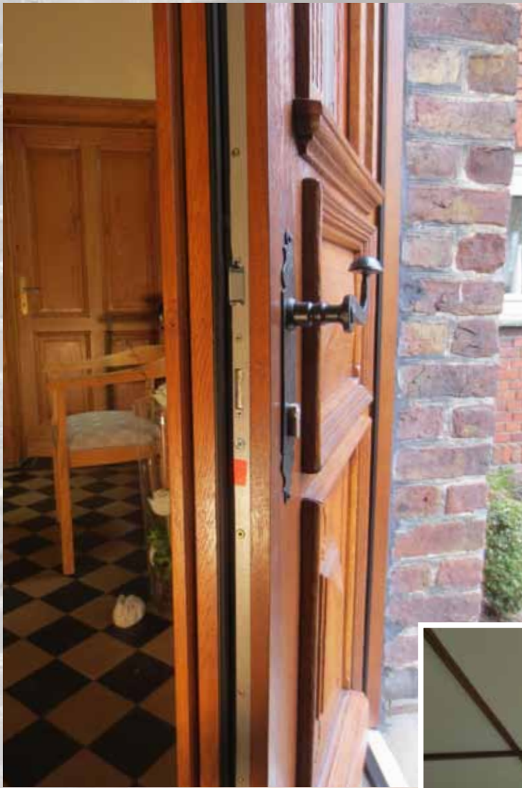
Modernes Haustürschloß mit Dreifachverriegelung und Profilzylinder.
